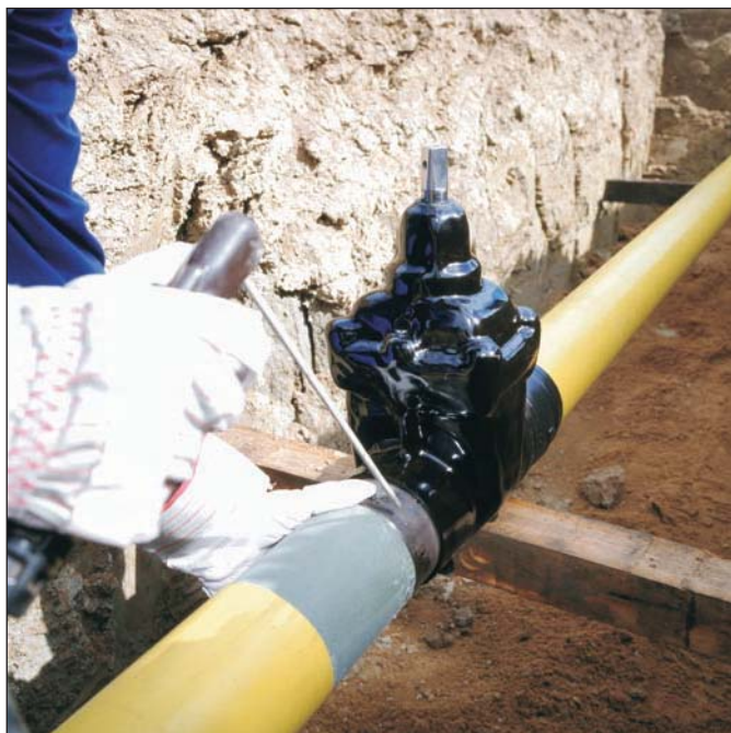
Свободный подход к стальным концам облегчает сварочные работы.
